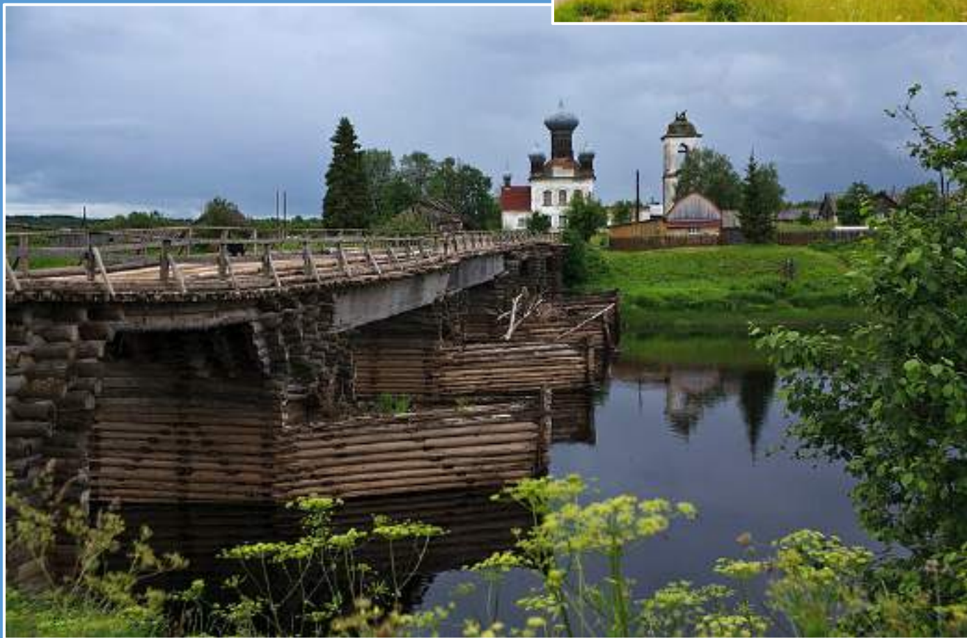
Деревянный ряжевый мост через речку Кена. Архангельская обл.
